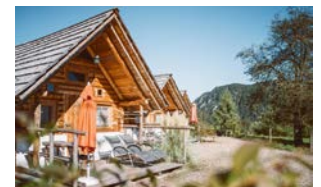
Blockhaus beim Laussabauer
